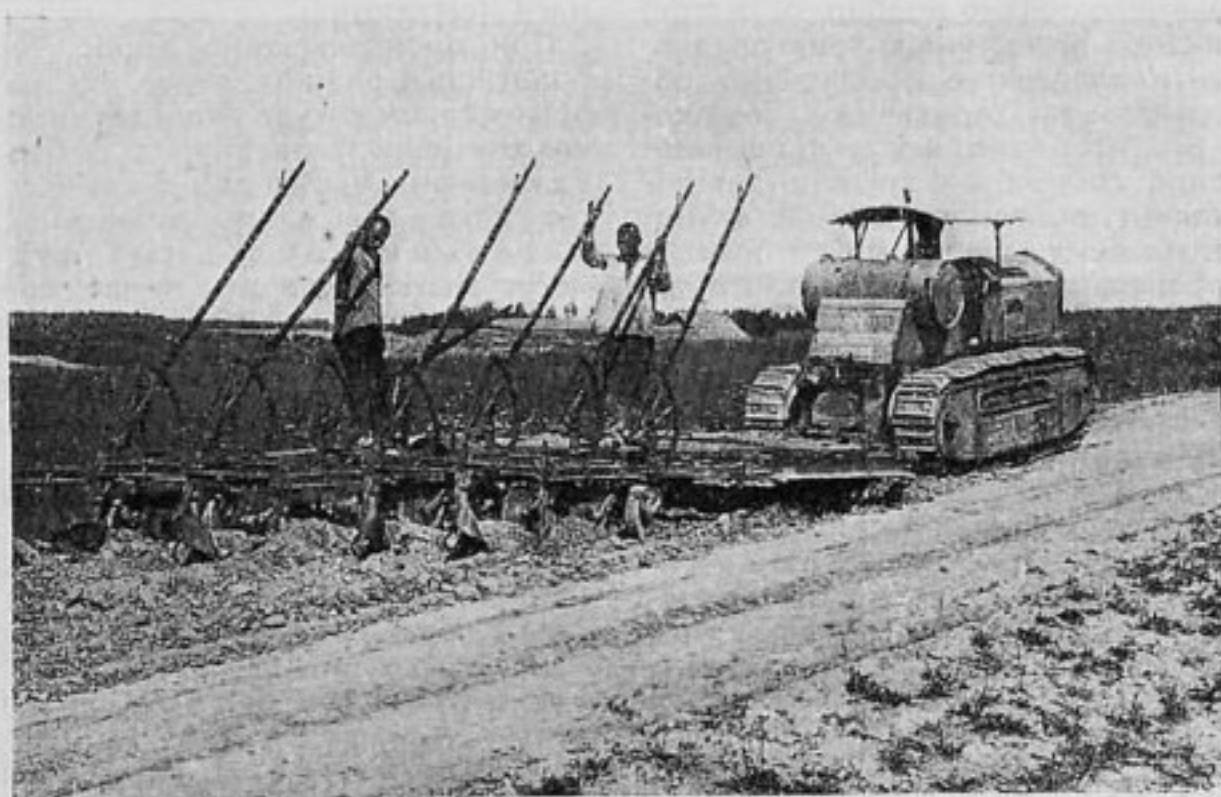
Советский гусеничный трактор „Большевик“ с мощным грейдером на дорожных работах
