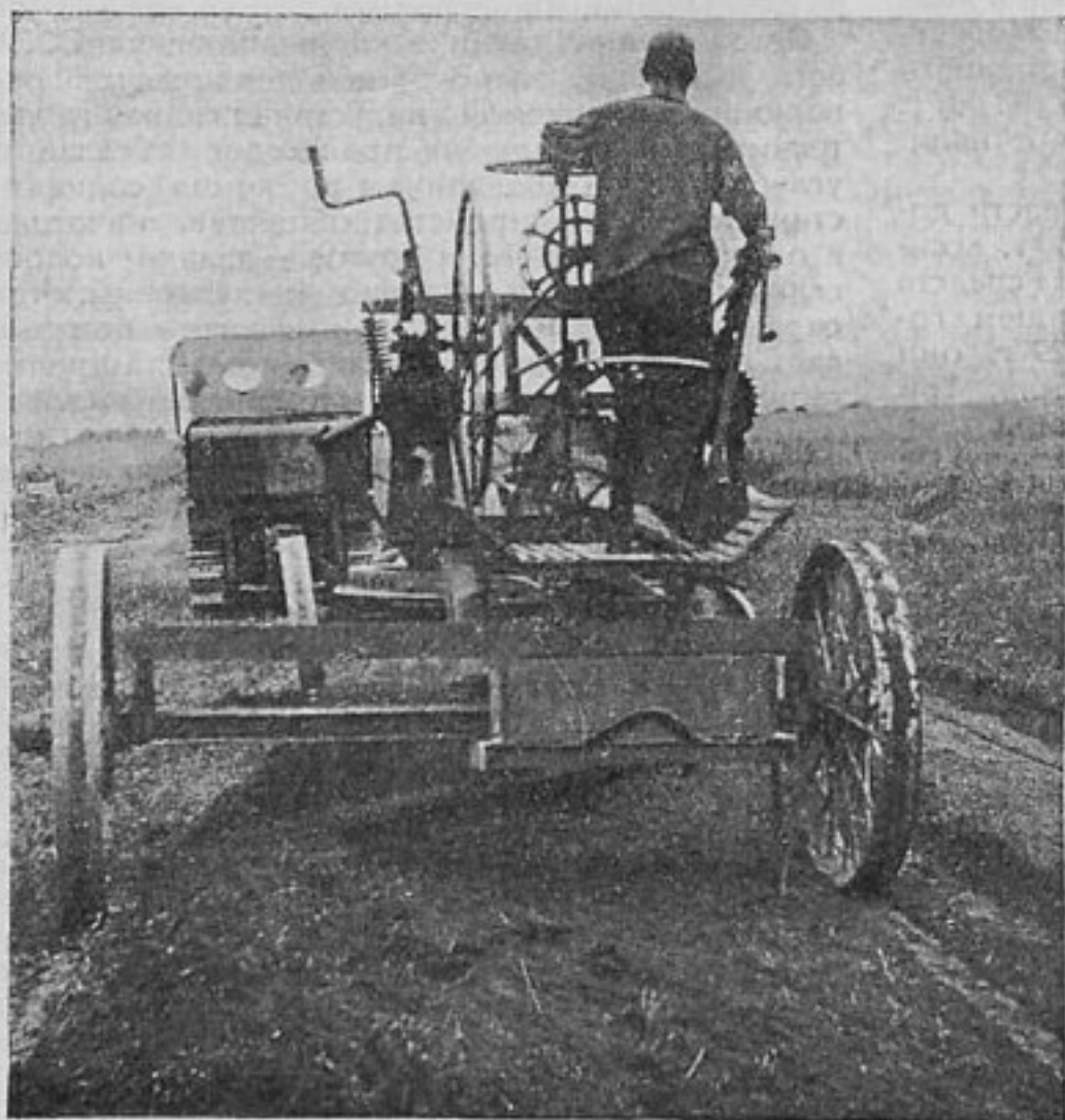
Дорожный струг (грейдер), работающий с гусеничным тягачем на полотне грунтовой дороги
