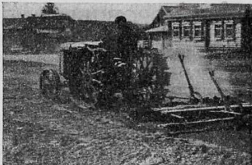
Утюжка грунтовой дороги трактором машинно-дорожного отряда МКХ
